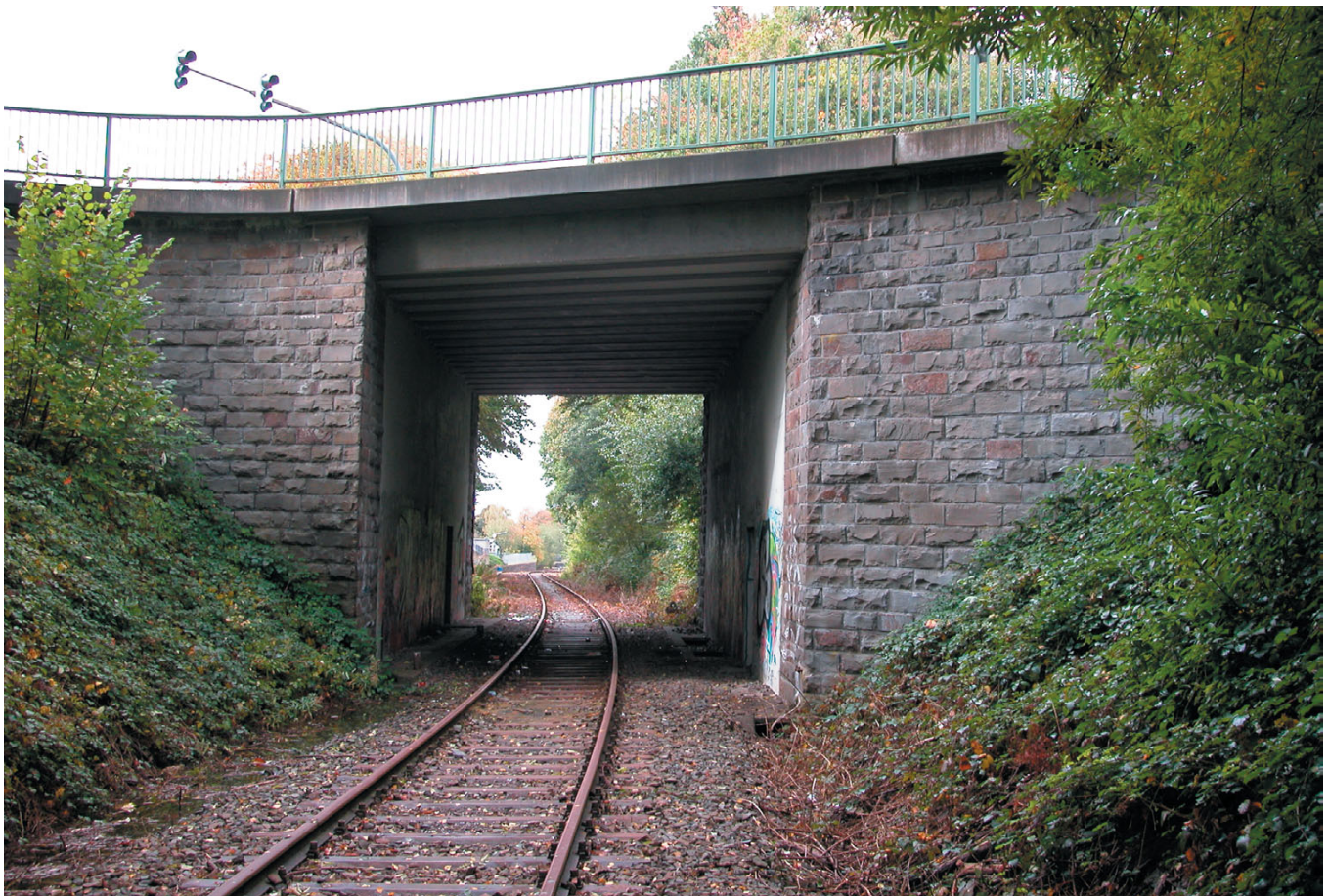
Beabsichtigt: Abriss der bestehenden Boxbergbrücke und Zuschüttung der vorhandenen Schienenunterführung
