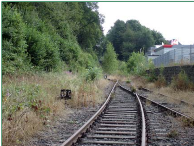
Bahnhofseinfahrt Waldbröl vorher ... (31. Juli 2005, Foto Ulrich Clees)
