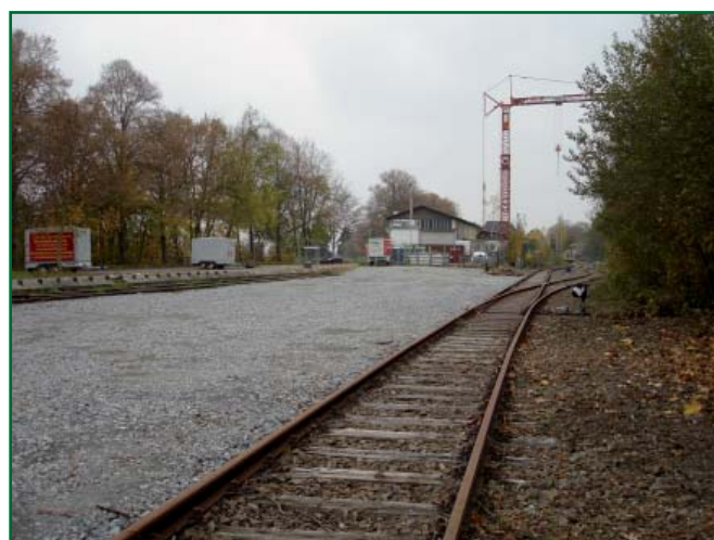
Die Fläche im Bereich der Ladegleise ist wieder nutzbar (28. November 2007, Foto Ulrich Clees).
