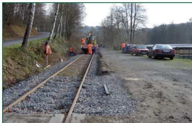
2. Schwellentausch und Schwellenköpfe freilegen (22.10.2006, Foto Ulrich Clees).
