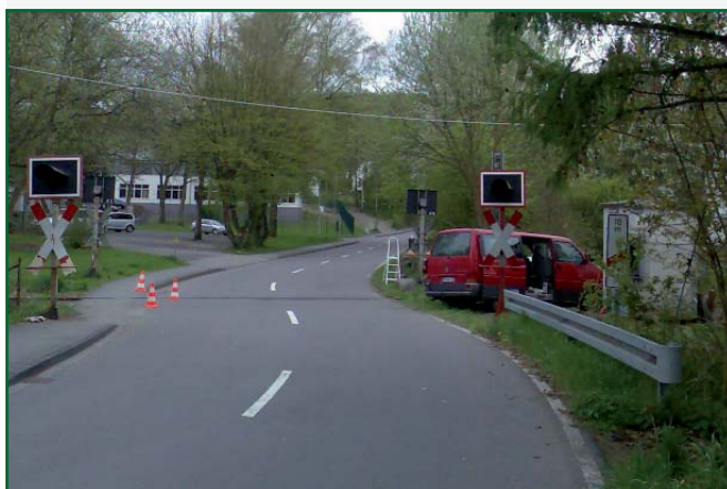
Sanierung der Anlagen (Frühjahr 2008, Foto: Wolf-Peter Rosenthal).
