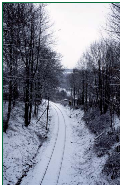
Im Jahr 2001 liegt der Einschnitt wieder frei (Foto Ulrich Clees).
