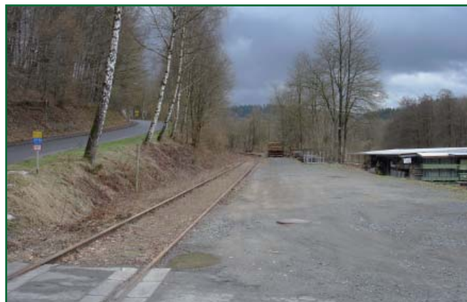
1. Freilegen des Gleises (1.4.2006, Foto Ulrich Clees).
