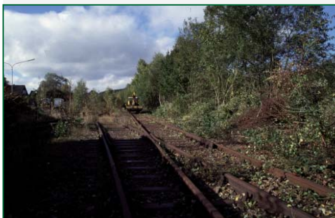
Erste Arbeiten in Oberwiehl (23. Oktober 1999, Foto Ulrich Clees).
