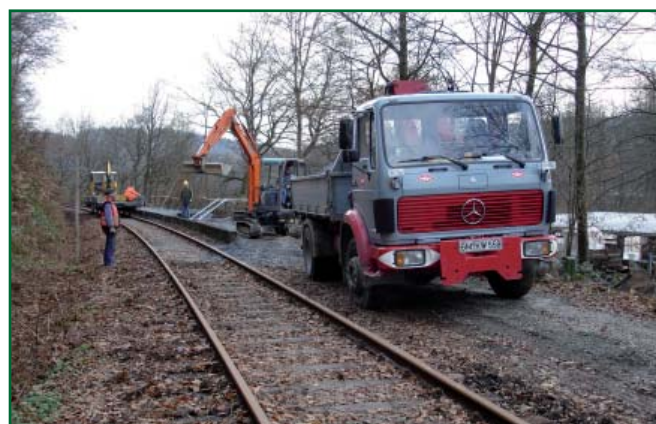
3. Bahnsteigsanierung (4.12.2006, Foto Ulrich Clees).
