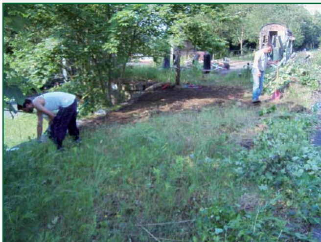
Sanierung der Laderampe (Juni 2007, Fotos Klaus Schade)
