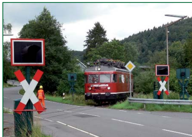
Wie hier in Sengelbusch wurden die Andreaskreuze, Blinklichter samt Blenden und die Antriebe erneuert. Zum Zeitpunkt der Aufnahme fehlten noch die Schrankenbäume (Der Turmtriebwagen ermöglicht durch seine Arbeitsbühne auf dem Dach z.B. Arbeiten an Brücken. 11. Juli 2007, Foto: Pattrick Brelöhr).
