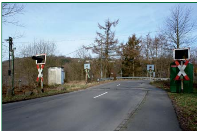
Der Bahnübergang in Brüchermühle: Andreaskreuze und Blinklicht-Blenden bedürfen der Aufarbeitung (17. Februar 2007, Foto: Ulrich Kissmann).
