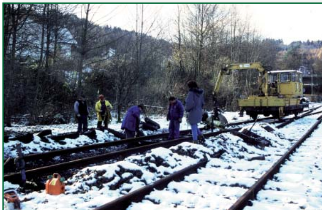
Weichensanierung für die Wiederinbetriebnahme (Wiehl, 20. November 1999, Foto Ulrich Clees).
