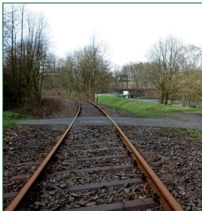
Die komplett freigelegte Strecke am 17. Februar 2007 (Foto Ulrich Kissmann).
